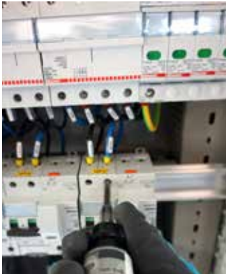
PROVA TIRAGGIO E SERRAGGIO
